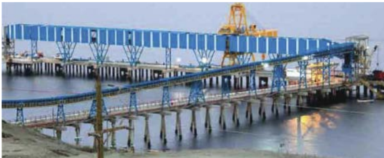
CONSTRUYEN EL FUTURO TERMINAL DE EMBARQUE DE CONCENTRADO
